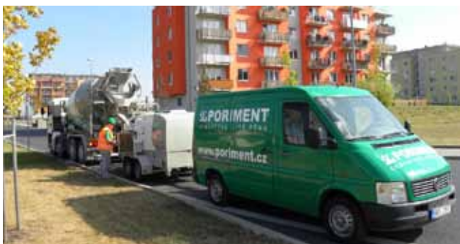
■ PORIMENT® - výrobní technologie na stavbě
