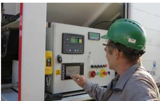
5 Čerpání litého potěru na stavbě z mobilní výrobní linky
