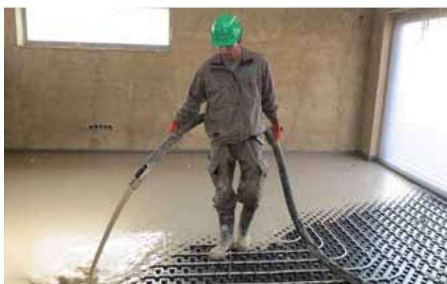
6 Realizace lité podlahy
