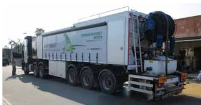
■ ANHYMENT® - mobilní výrobní zařízení na stavbě
