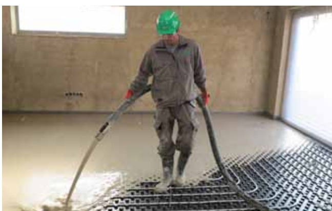
6 Realizace lité podlahy
