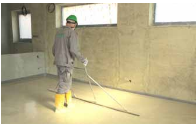
8 Nivelace - konečné urovnání litého potěru
