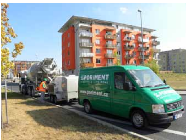
■ PORIMENT® - výrobní technologie na stavbě
