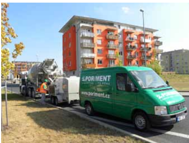
■ PORIMENT® - výrobní technologie na stavbě
