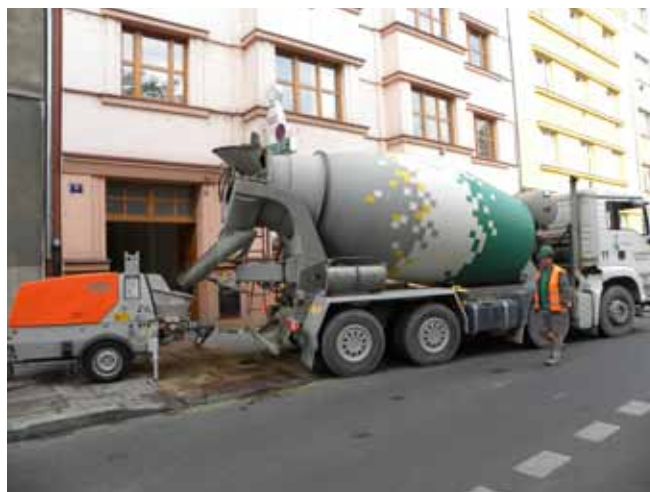
■ CEMFLOW® - rekonstrukce podlah v bytovém domě
