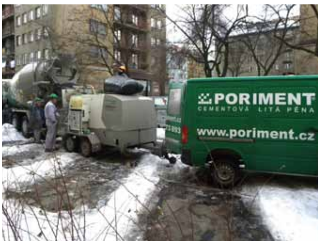
■ PORIMENT® - rekonstrukce podlah v bytovém domě
